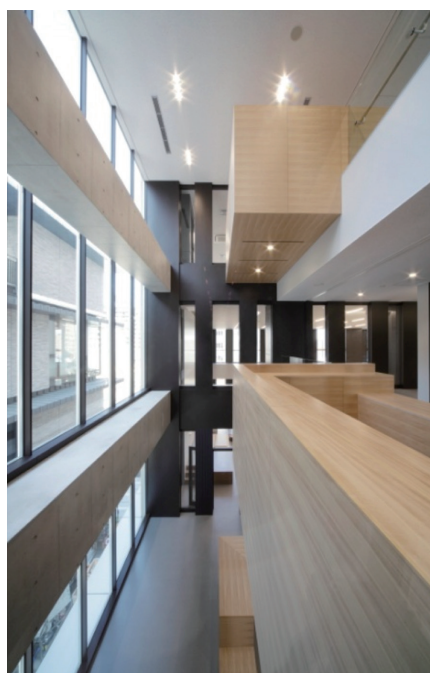
3～5階は吹き抜けになっていて、館内の自然換気を助けている
